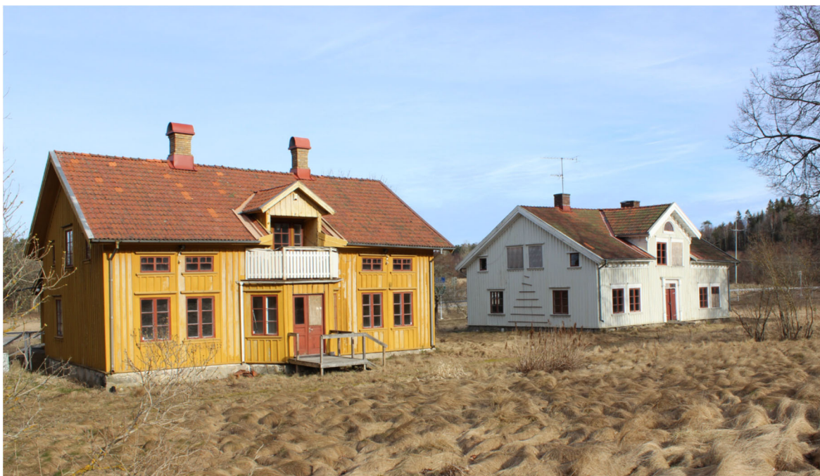
Bild som visar de kulturhistoriskt värdefulla byggnaderna på Stormansgården 3.
