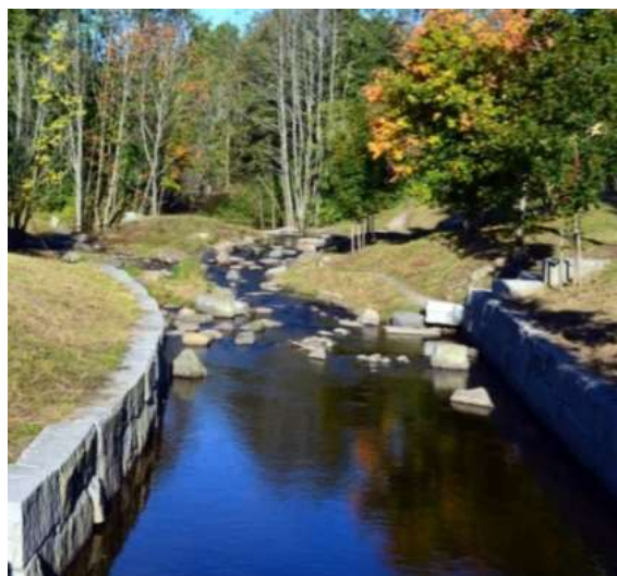
Figur 12. Illustration av en delad bäcksektion, en "hård" (uppströms) och en "mjuk" (nedströms). Bilden är från en mindre, öppnad bäck i Oslo (Oslo Vann, 2015).
