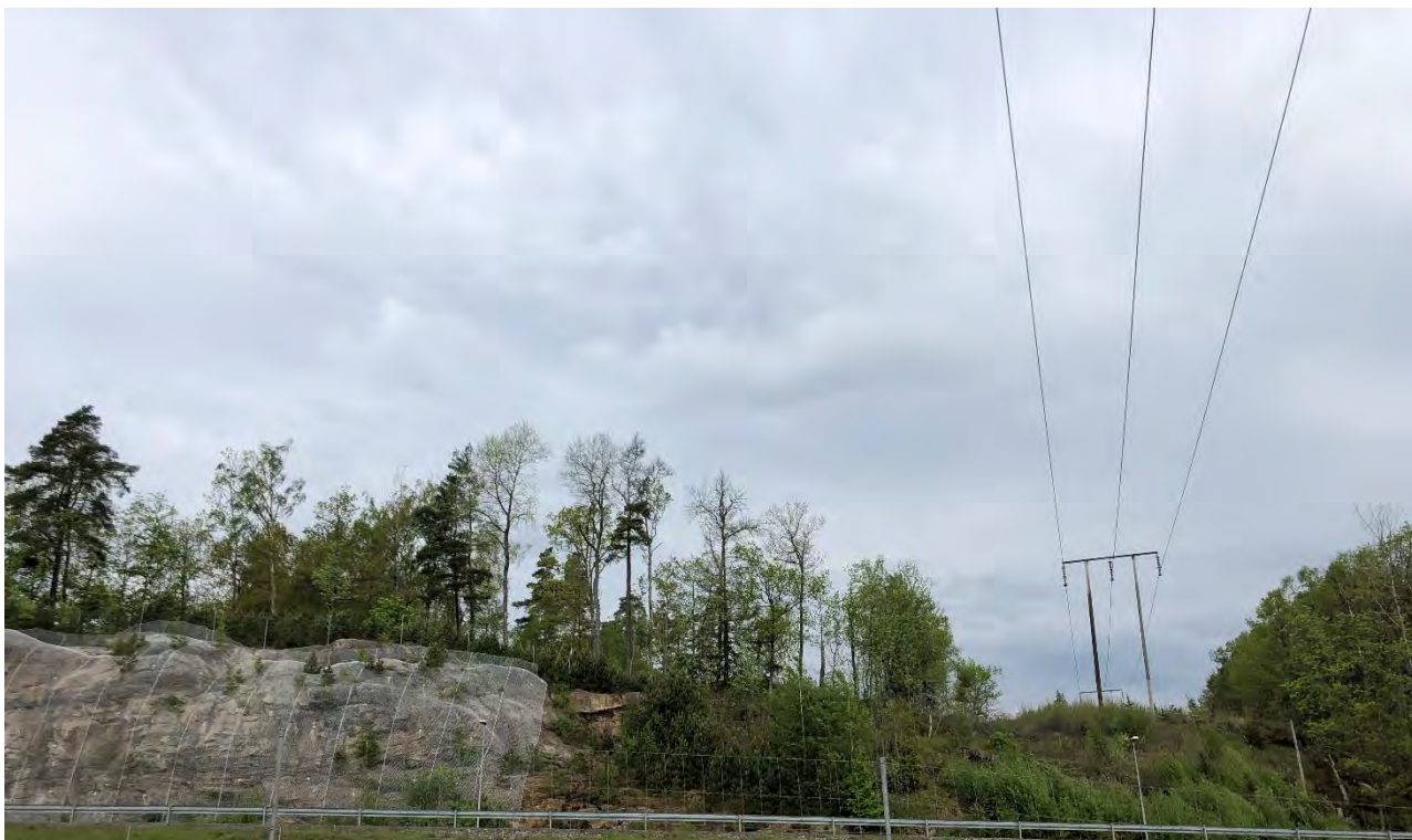
Figur 49. Luftledningen som löper genom planområdet och kommer markföras vid genomförande av planen. Foto: Jesper Adolfsson.
