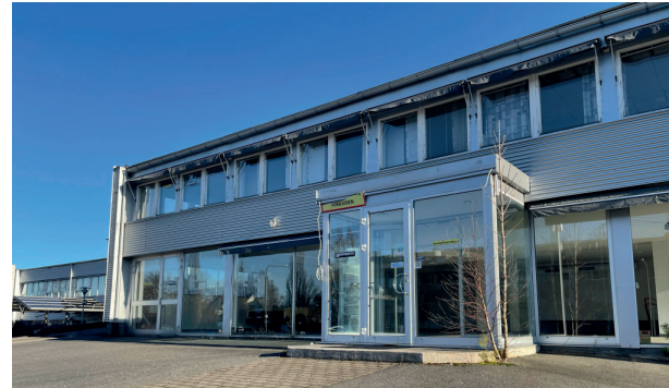
Befintlig byggnad på tomten
