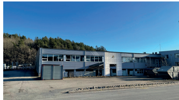
Befintlig byggnad på tomten
