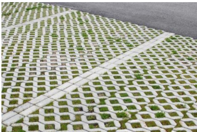
Figur 16. Exempel på betongraster med gräs på parkeringsplats (Vinnova, 2014)
