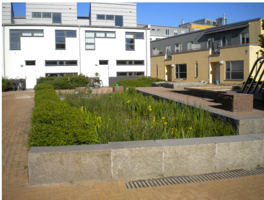
Figur 17. är ett exempel på hur en regnbädd kan se ut. Foto från västra hamnen i Malmö.
