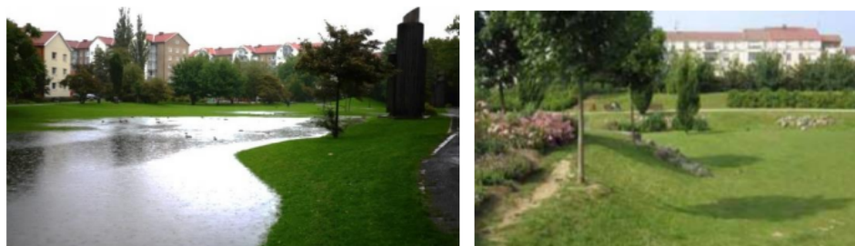
Figur 14. Två foton på torrdammar: till vänster en vattenfylld (Boverket 2019) och till höger en tom damm (Uppsala Vatten, U.å).
