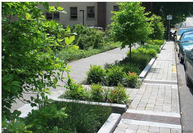
Green Street Portland, USA. Dagvatten leds via rännor under trottoaren till regnbädden, där det fördröjs och renas. Källa: City of Portland
