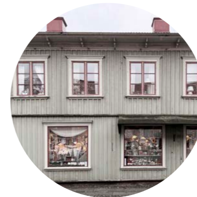
FÄRGSATT KARM/SPRÖJS DETALJERADE FÖNSTEROMFATTNINGAR
