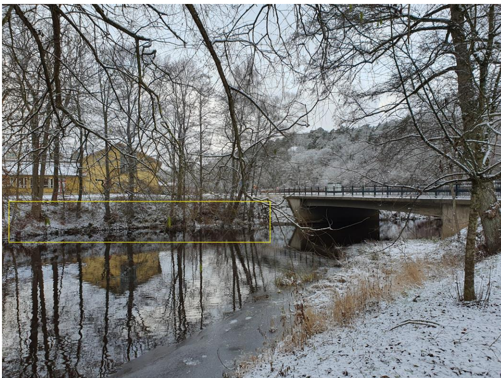
Figur 8. Område nedströms från västra brofästet med stort erosionstryck, tillika åtgärdsområde 1, markerat i gult.
