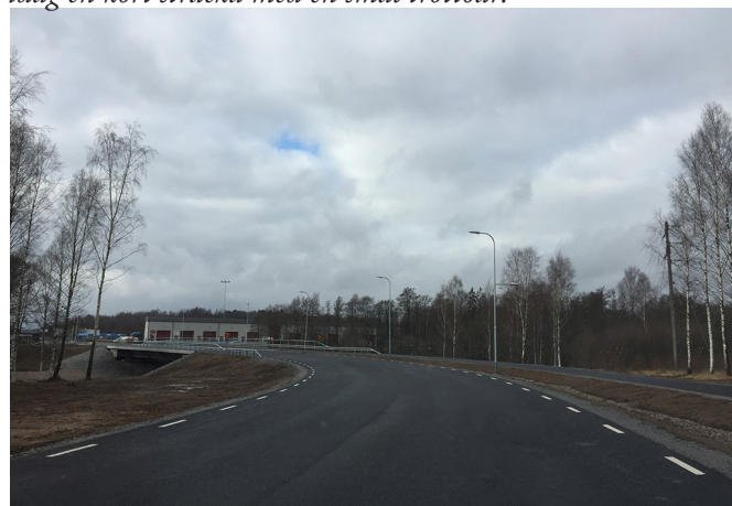
Längs Tokebackavägen finns en nybyggd gång- och cykelväg som slutar på andra sidan bron, där Borgens gata börjar.
