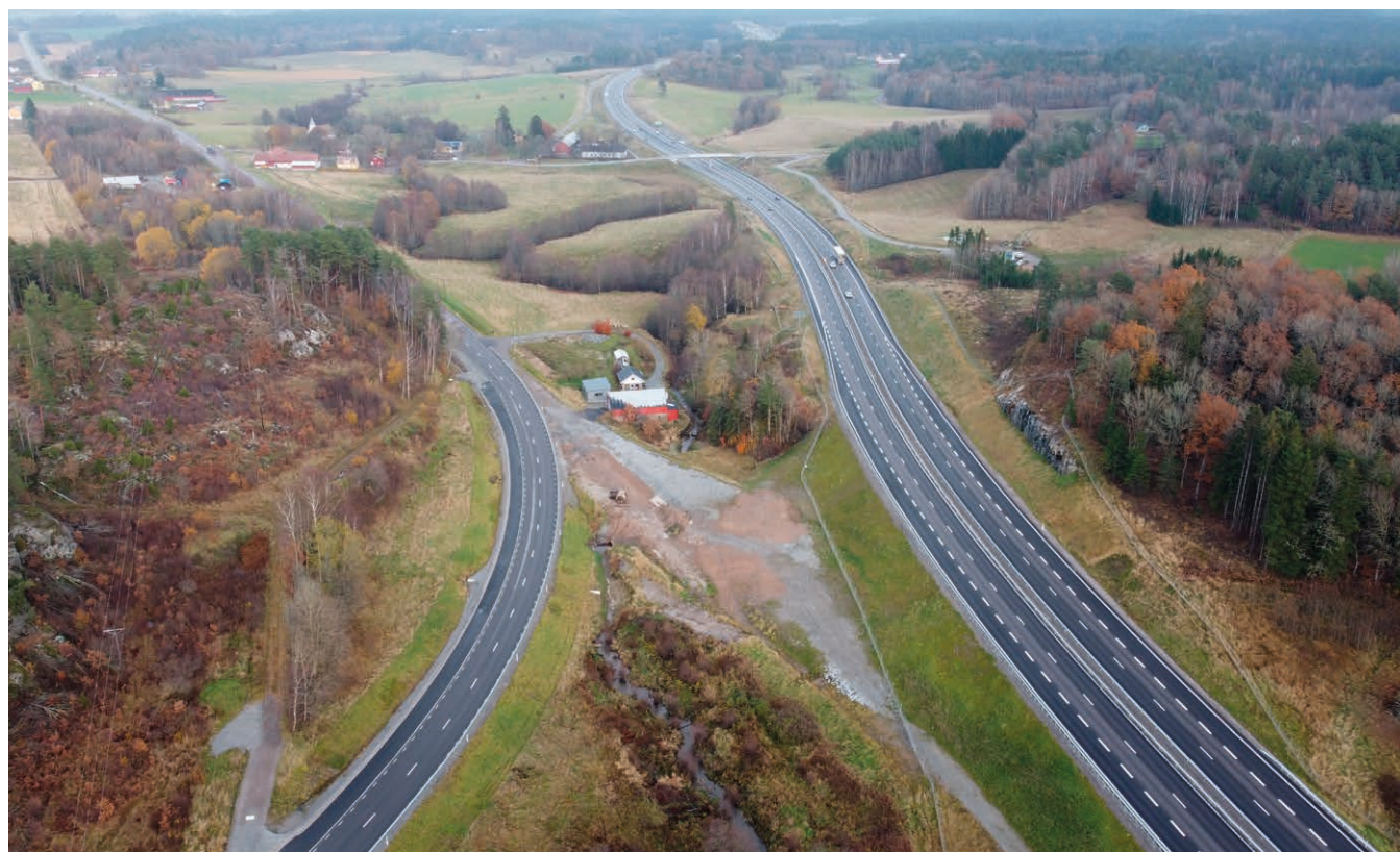
Figur 4. Flygfoto över E20 till höger och väg 1900 (gamla E20) till vänster.
