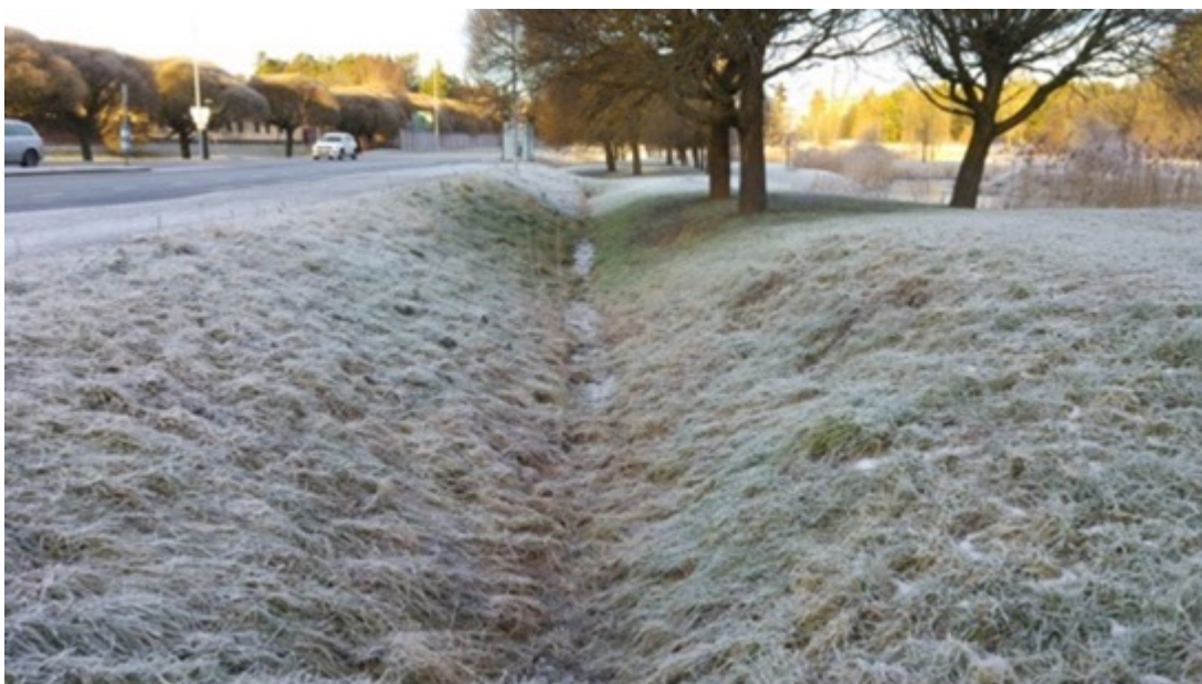
Figur 14. Exempel på Svackdike. (Foto: Geoveta)
