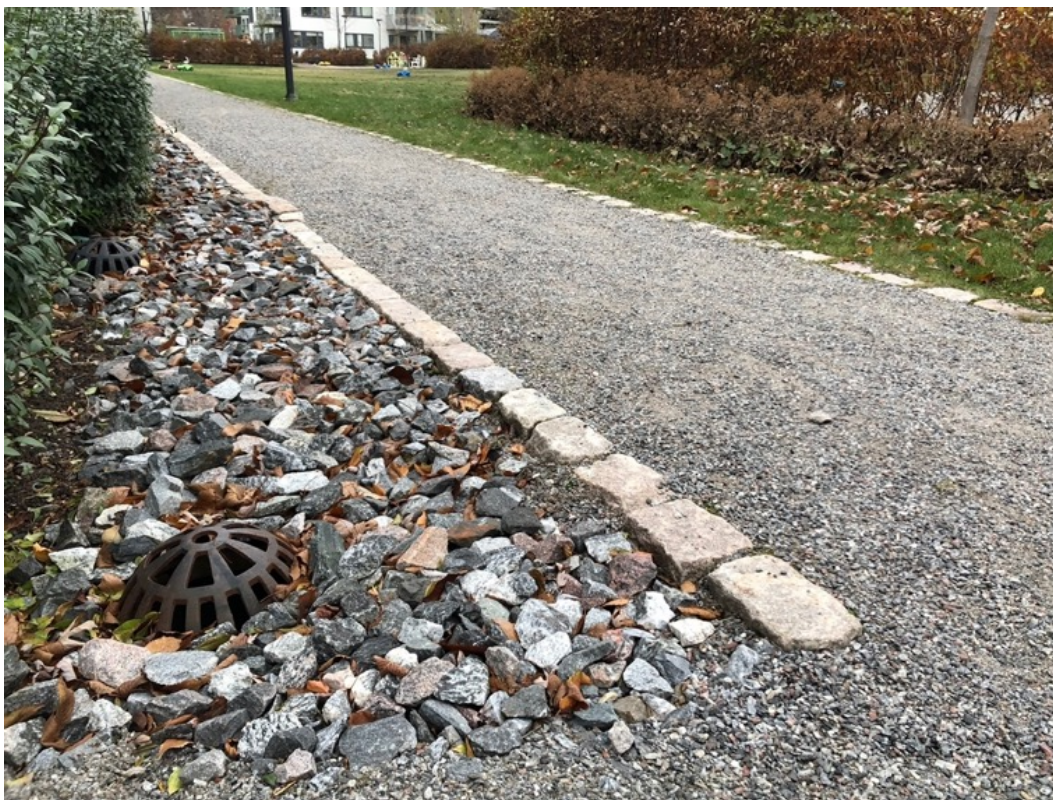
Figur 12. Krossdike med upphöjd kupolbrunn i Beckomberga, Stockholm. Kan anläggas i gator med mindre ytor. (Foto: Geoveta)
