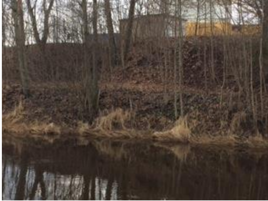
Figur 5. Slänt i anslutning till befintlig bro i väster (källa COWI AB 2017-01-23)
