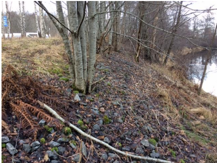
Figur 6. Foto över erosionsskydd i de centrala delarna av området (källa: COWI AB 2017-01-23)
