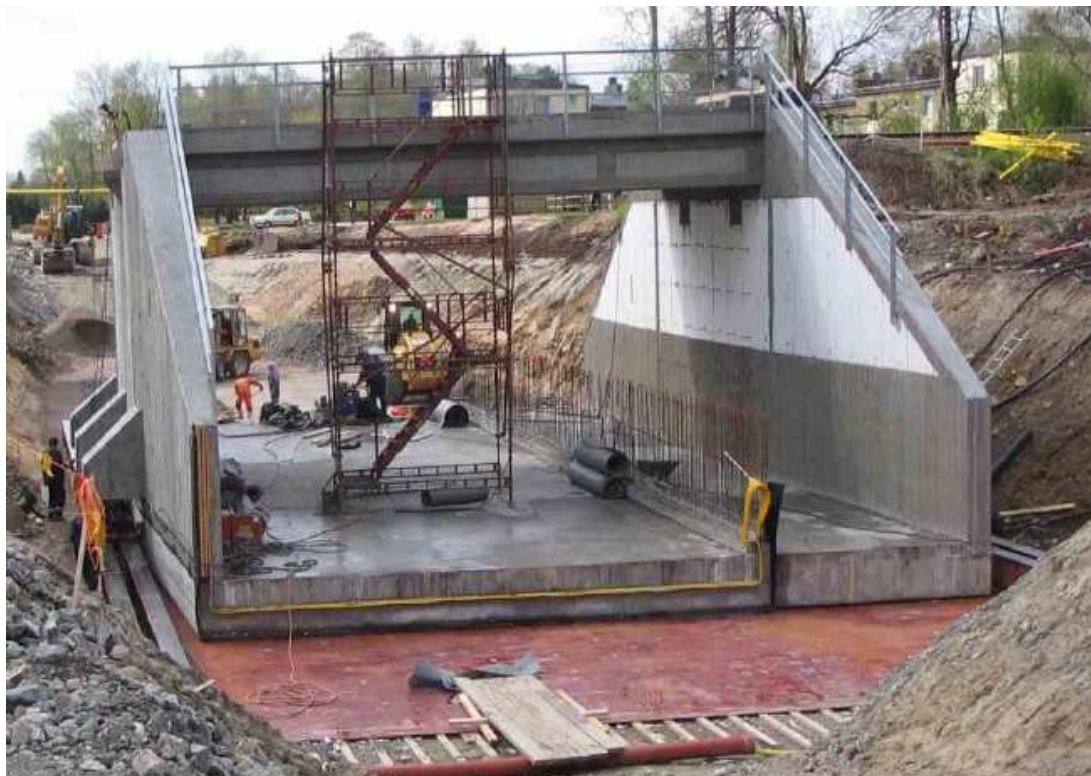
Figur 6 – Exempel på plattrambro som lanseras in från sidan.
