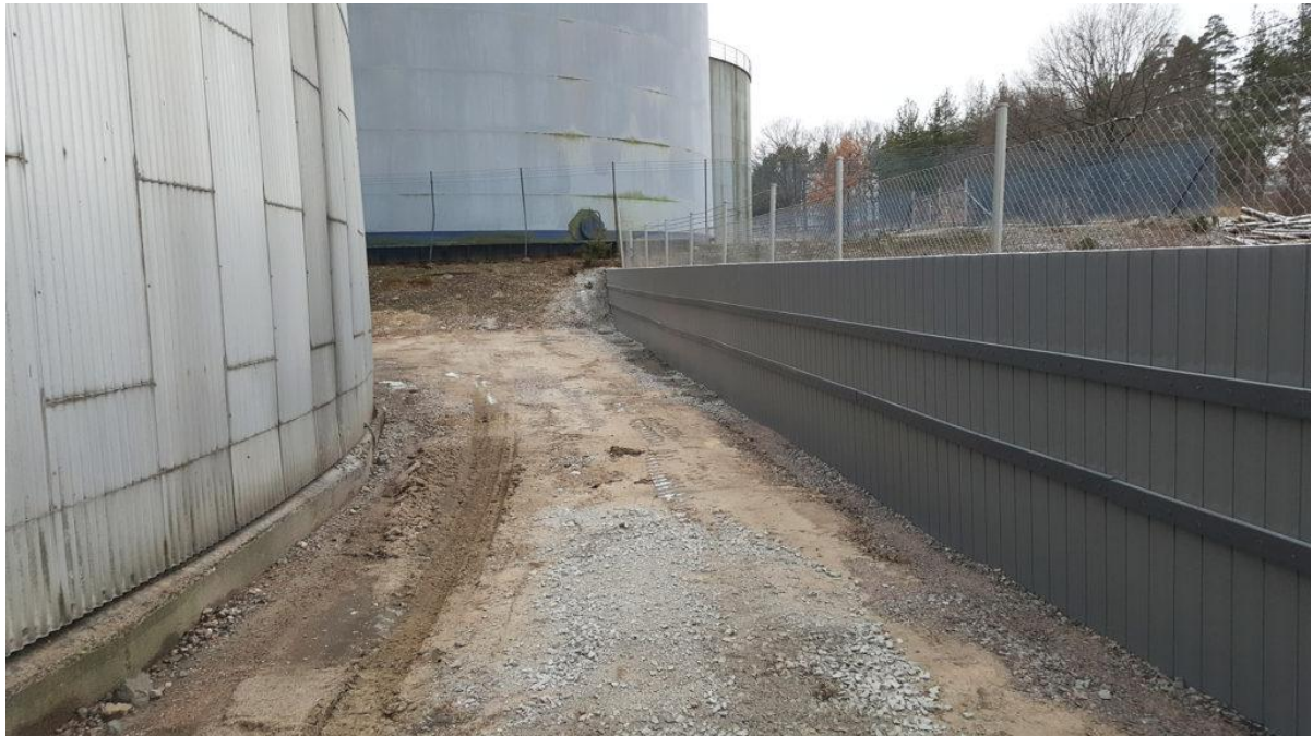
Figur 6. Exempel på tätskärm av Aqvis plastspons från oljehamnen i Norrköping. (Källa: Aqvis)
