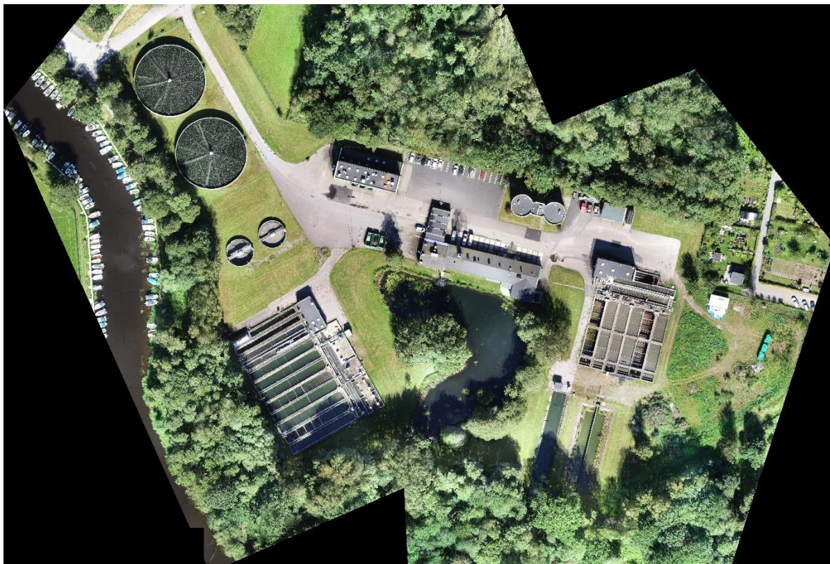
Figur 9. Flygbild av befintligt reningsverk 2020 Källa: drönbild PEAB 2020.
