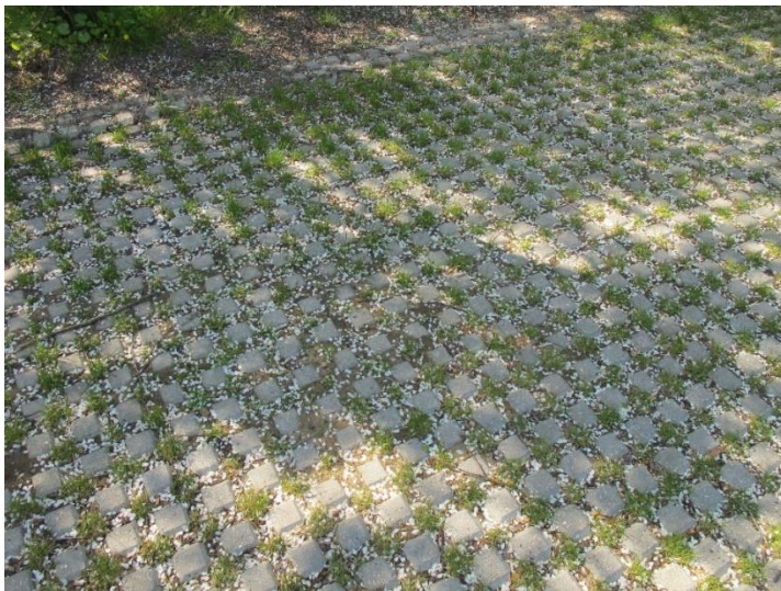
Figur 20. Exempel på gräsarmeringssten, foto Ramboll.
