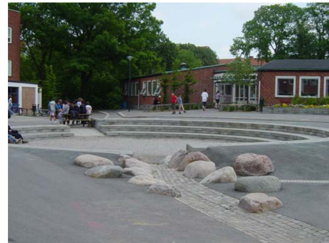
Fig. 66 Exempel på multifunktionsyta med uteklassrum och utjämningsmagasin, Augustenborg Malmö (foto Krister Jansson)
