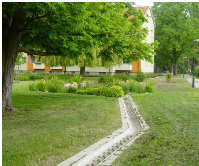
Fig. 65 Exempel på avledning i öppet system med betongkanaler, Malmö (foto Krister Jansson)
