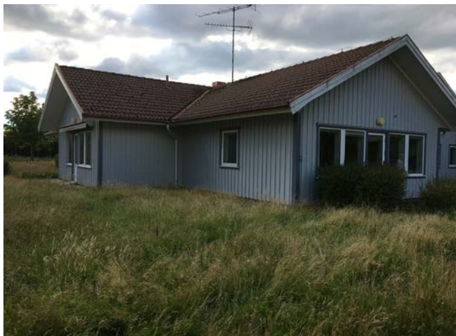
Fig. 55 Befintlig bebyggelse vid Korngatan, ett tidigare gruppboende som står tomt.
