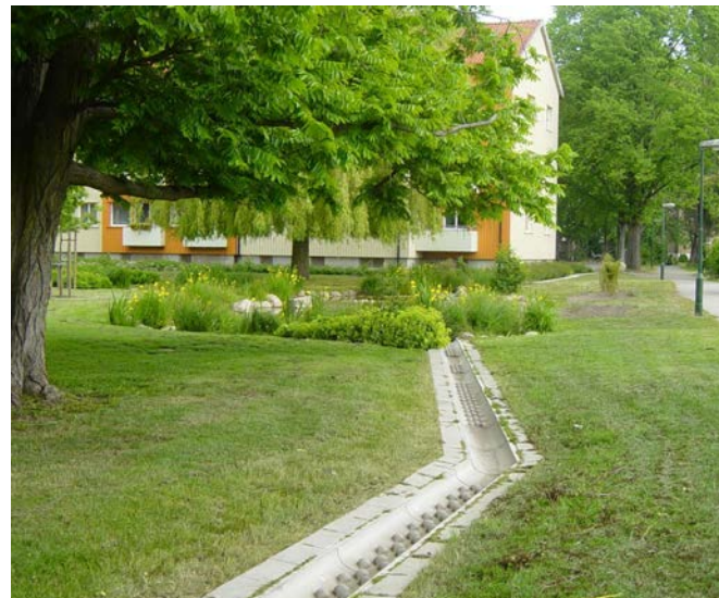
Fig. 65 Exempel på avledning i öppet system med betongkanaler, Malmö (foto Krister Jansson)
