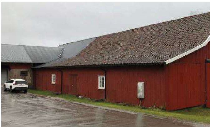
Ladan tillhörande Toresgården med befintlig verksamhet.
