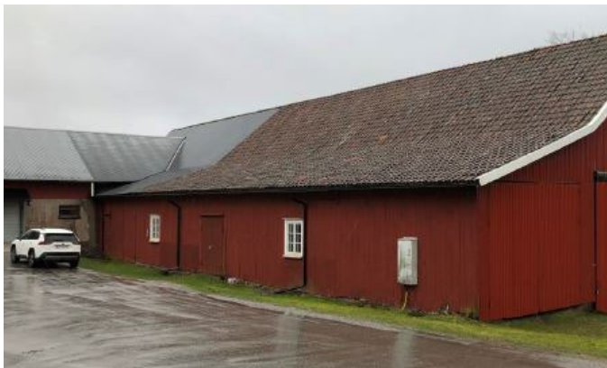
Ladan tillhörande Toresgården med befintlig verksamhet.
