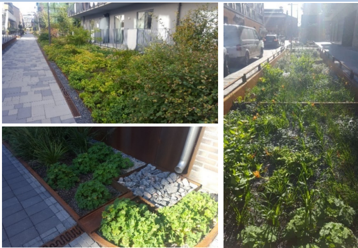
Exempelbilder nedsänkta växtbäddar. Foto: Sweco
