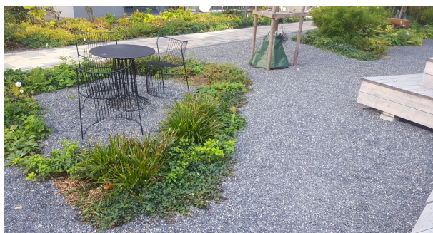
Exempelbild genomsläpplig beläggning. Foto: Sweco
