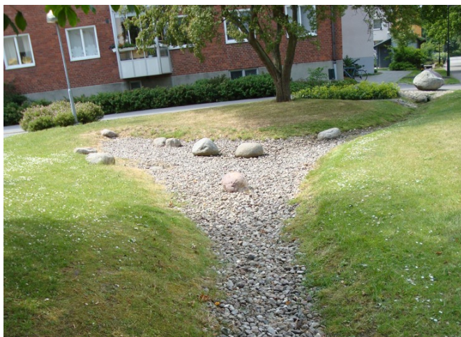
Exempelbild makadamdike. Foto: Sweco
