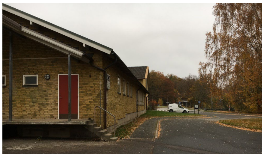
Figur 10 Befintlig lastzon vid Nolhagaskolans östra sida intill vändplatsen.
