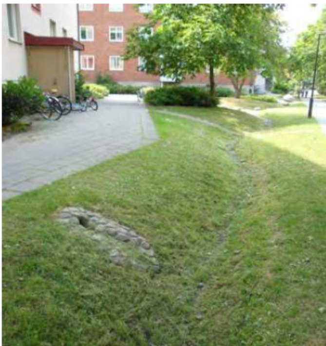
Figur 13: Exempel på Svackdike. Källa: RG dagvattenhandbok.
