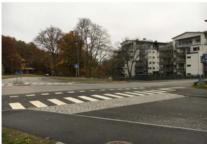
Befintlig gång- och cykelpassage över Nolhagagatan och vändslinga som leder trafiken in till skolområdet.
