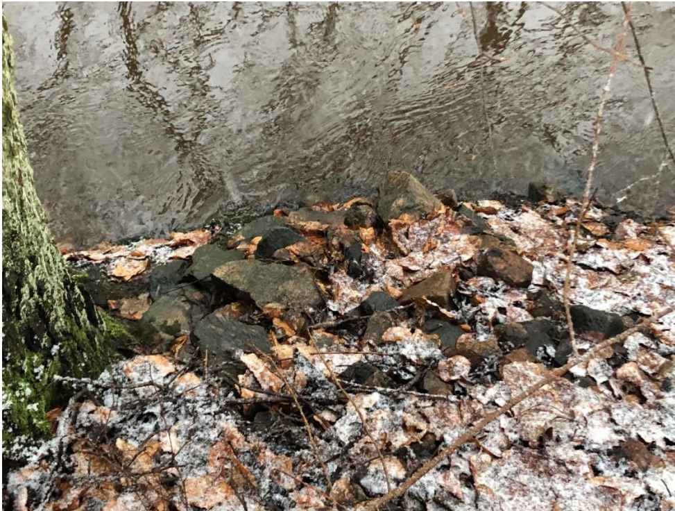
Figur 5. Synlig del av erosionsskydd. (Foto: Svante Roupé)
