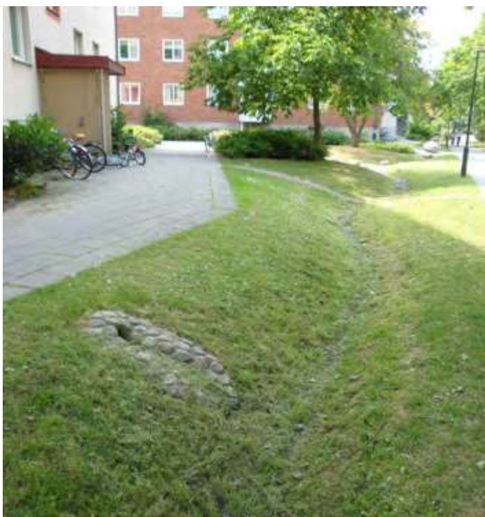
Figur 13: Exempel på Svackdike. Källa: RG dagvattenhandbok.
