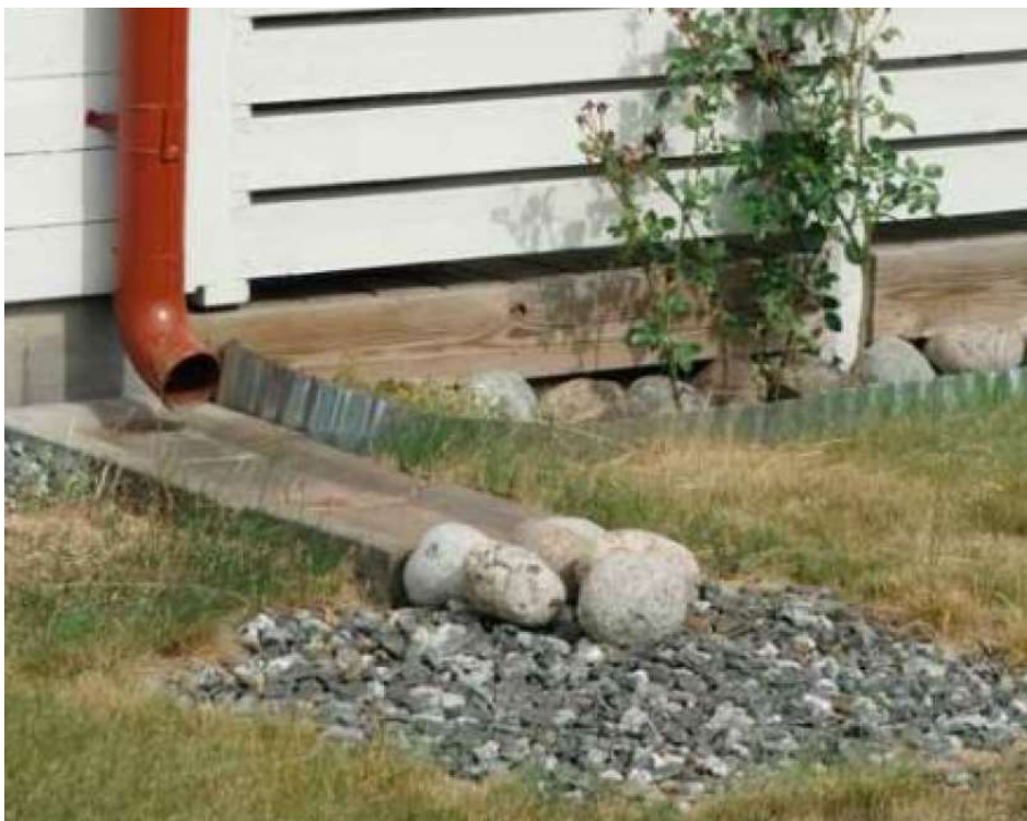
Figur 11: Stuprörkastare med rännvidsplattor med erosionsskydd som leder ut vattnet på gräsmatta. Foto: Dagvattenhandbok Haninge kommun 2019.
