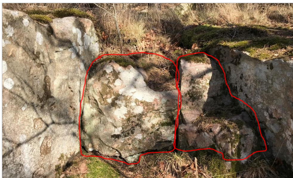
Figur 18. Två block sitter fastkilade mellan brantgående sprickor, vid observationspunkt 22.
