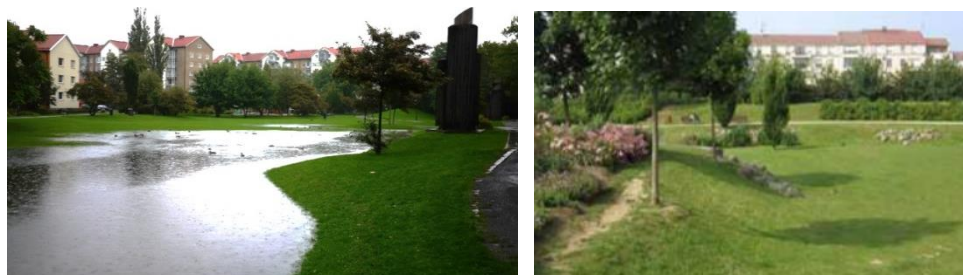
Figur 22. Två foton på torrdammar: till vänster en vattenfylld (Boverket, 2019) och till höger en tom damm (Uppsala Vatten, u.å.).
