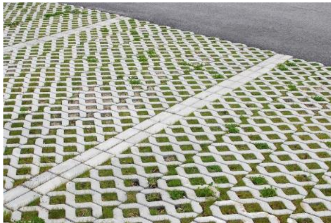
Figur 24. Exempel på betongraster med gräs på parkeringsplats (Vinnova, 2014)
