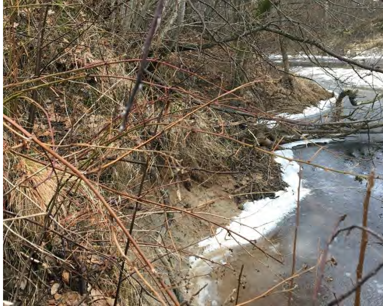
Figur 7. Förekommande erosion i de västra delarna av området anslutning till undersökningspunkt CW04 (källa: COWI AB 2017-02-16)
