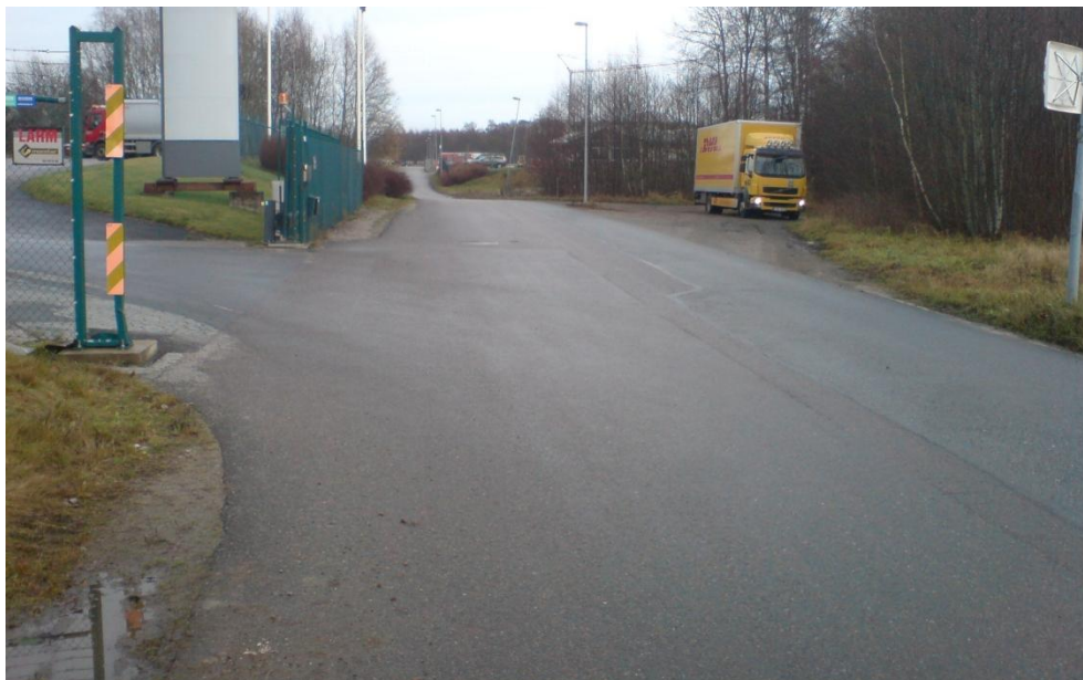
Bild 2. Borgens gata, vy åt nordost.
