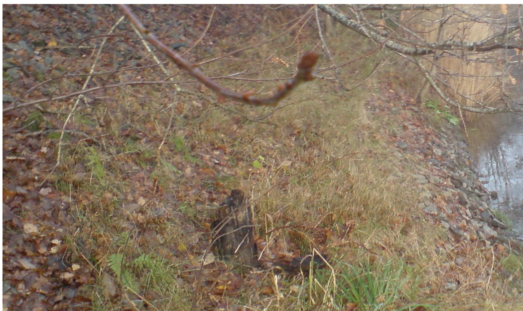
Bild 5. Exempel på påträffat erosionsskydd för aktuellt område.
