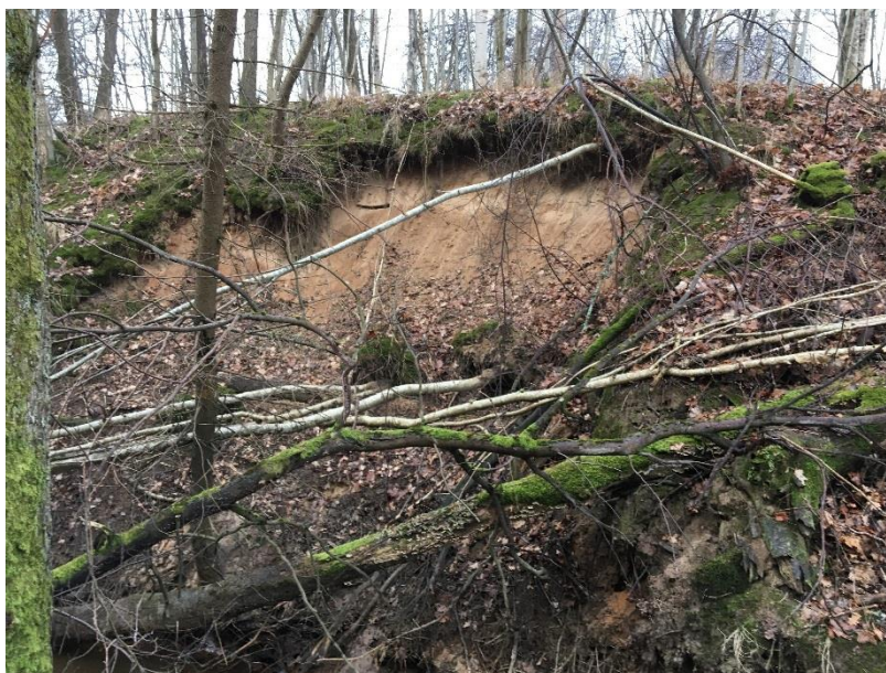
Figur 9. Pågående erosion i anslutning till troligt dagvattenutlopp (källa: COWI AB 2017-02-16)
