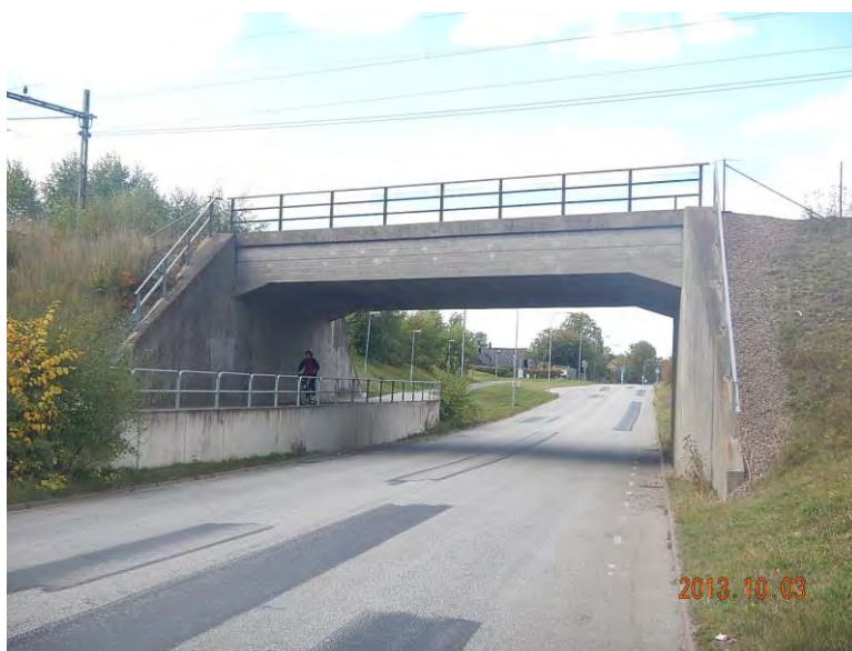
Figur 22. Liknande brokonstruktion vid Eslöv, Harjägersvägen.
