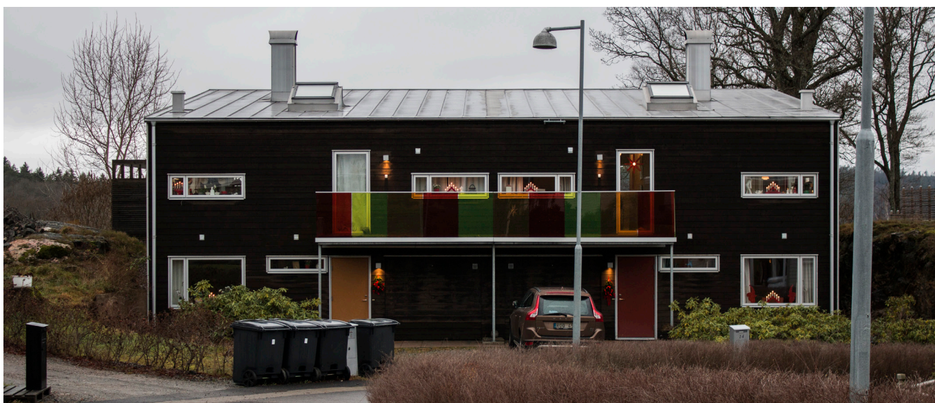
Parhuset sett från Tallbackegatan med entréer samt inbyggda garage
