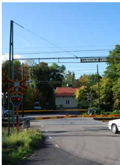
västra Bodarnevägen korsar järnvägen
