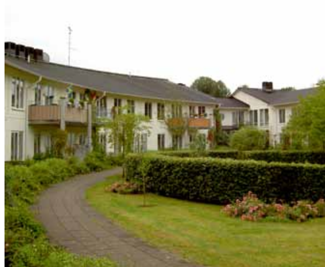
Kaptenen: Gråbovägen 37 A-C, 441 50 Alingsås - har en grönskande innergård och ligger i närheten av vårdcentralen och Ångaboskolan.
